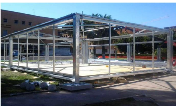
Figura 14 - Esempio struttura prefabbricata
